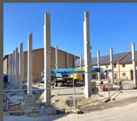
Bodenplatte und Trägersäulen werden gesetzt
