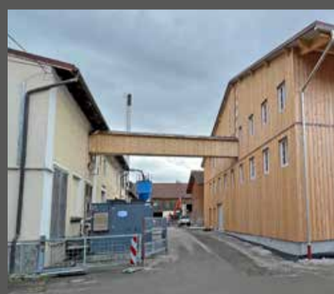
Das alte Sudhaus und der Lagerkeller werden mit der Abfüllanlage verbunden.
