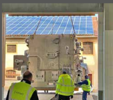
Die ersten Maschinen werden eingebracht und platziert.
