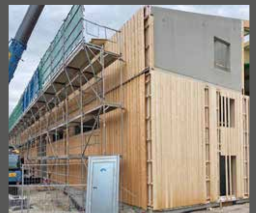
Fassadenarbeiten an der neuen Füllerei
