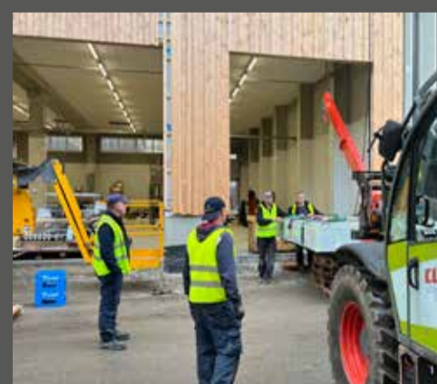
Weitere Bauteile werden täglich angeliefert und eingebaut.
