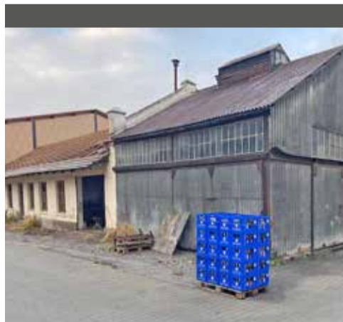
Die alte Schreinerei direkt vor dem Abriss
