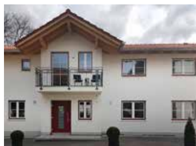
Der Neubau für Übernachtungsgäste
